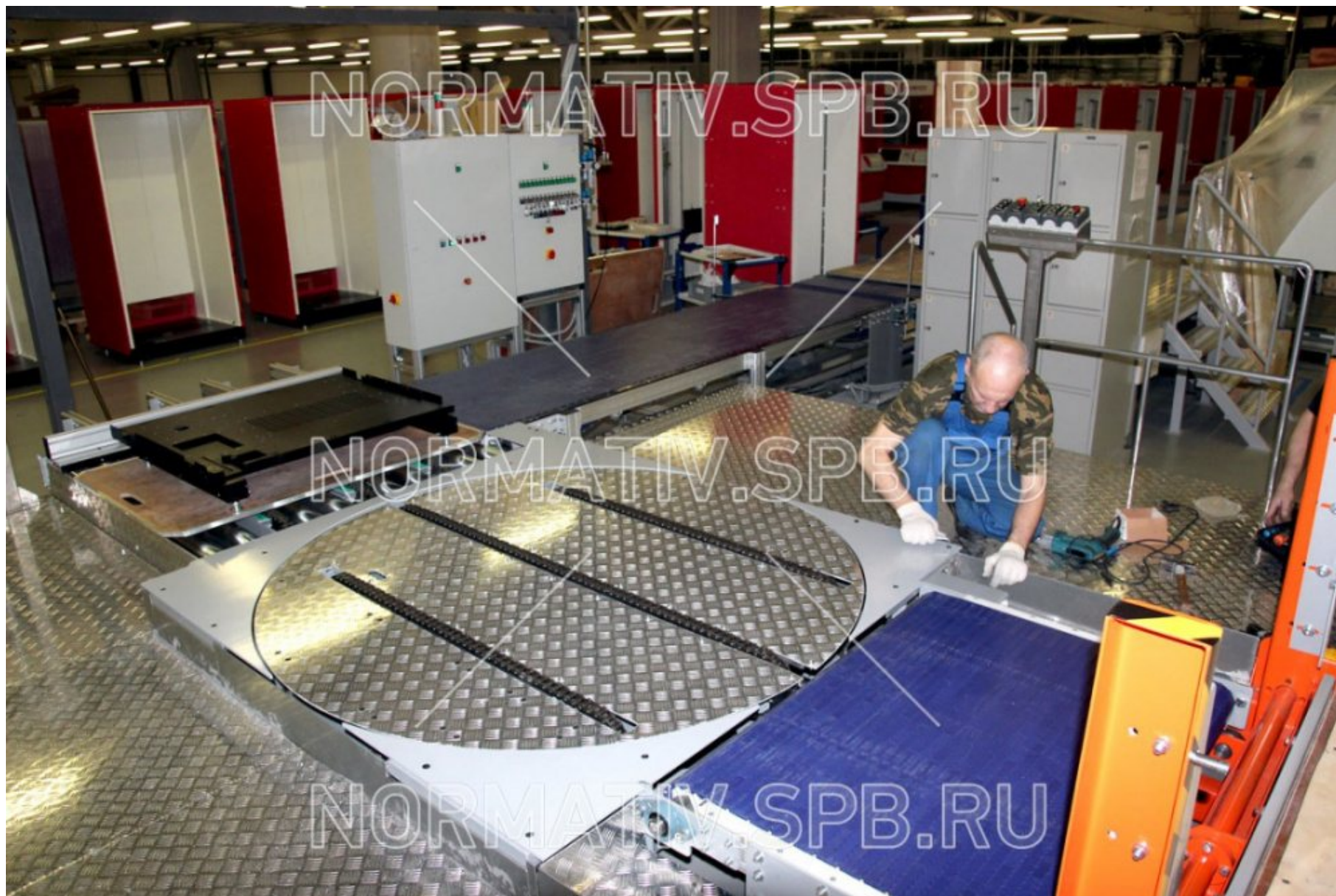
Поворотный стол для Линии сборки вендинговых (снековых) автоматов. Монтаж.
